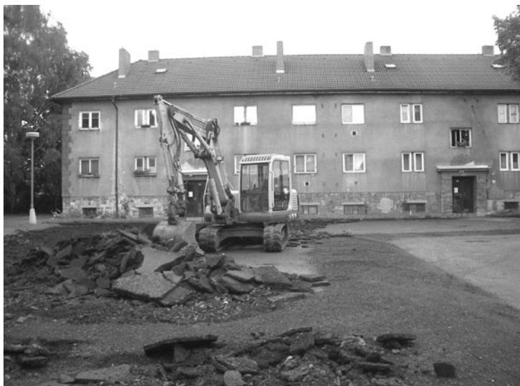
Práce na revitalizaci lokality za nádražím začaly.
