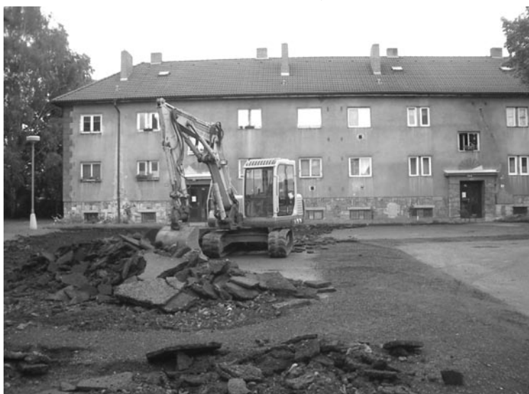
Práce na revitalizaci lokality za nádražím začaly.
